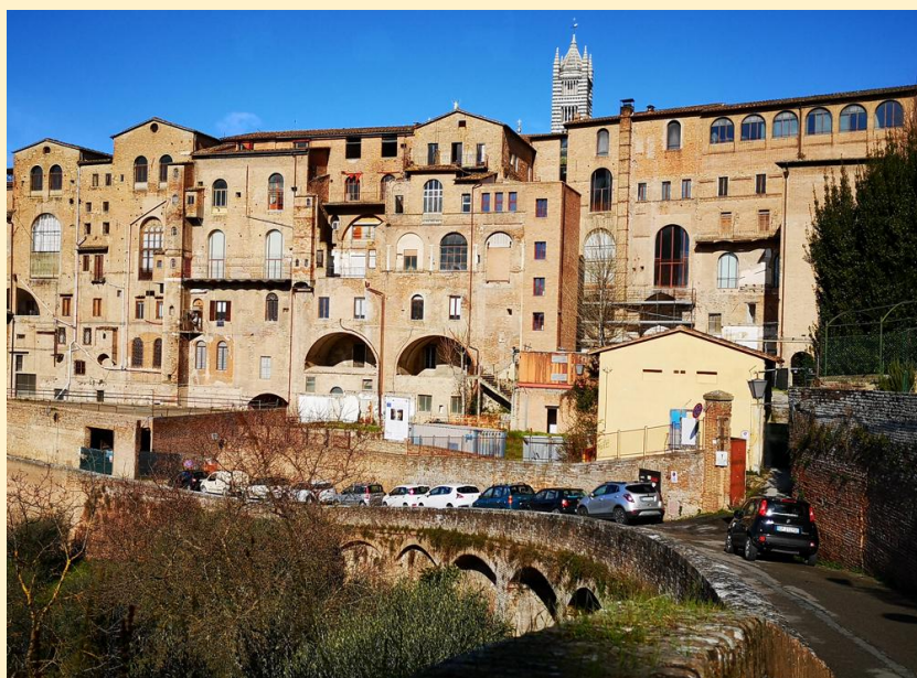
Il complesso visto da via Fosso di Sant'Ansano
